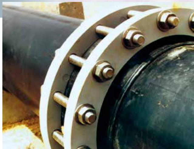
**PN** : La pression nominale indique l'aptitude à résister à une pression d'eau intérieure. Elle correspond à la valeur en bars (PN3 à PN25) d'une pression maintenue constante, que l'élément de canalisation doit supporter sans défaillance et avec une sécurité convenable pendant 50 ans à la température de 20°C.
