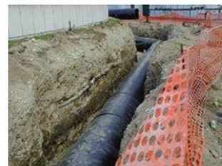
Lorsque la conduite est installée en tranchée, le poids des terres et la résultante des forces de frottement contre la paroi du tube contrarient l'allongement du tube.
