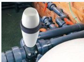
Cette option permet de monter provisoirement ou totalement le Blue Connect sur une canalisation par l'intermédiaire d'un collier de prise en charge fourni Ø50 mm.
